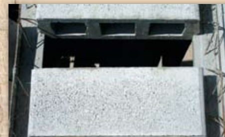
Espacio para Instalación eléctrica
